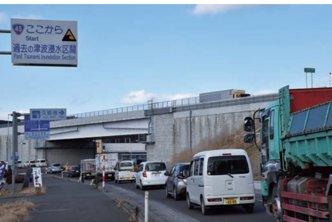
高台を走るのが昨年12月に全線開通した三陸沿岸道路。沿岸部を走る国道45号が震災で機能不全に陥ったことから、整備が進められていた
