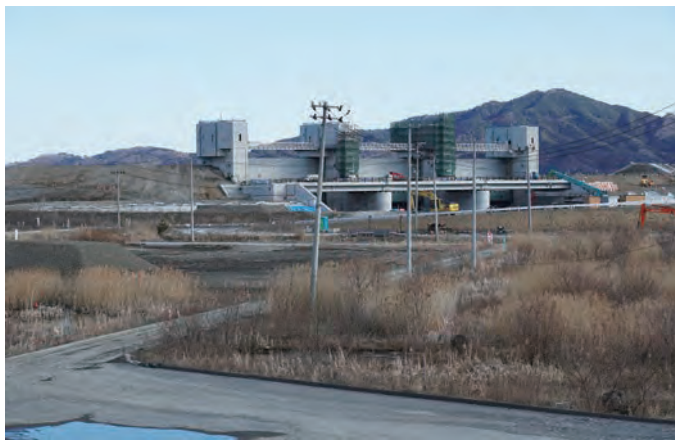
巨大な水門が作られている
