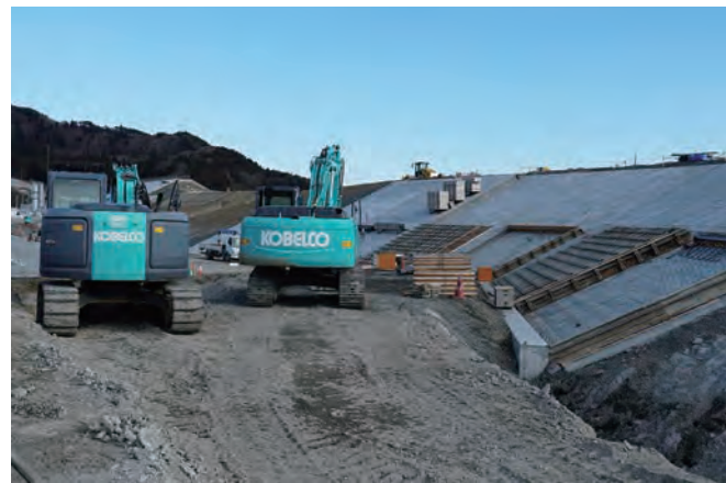
防潮堤の工事が進む
