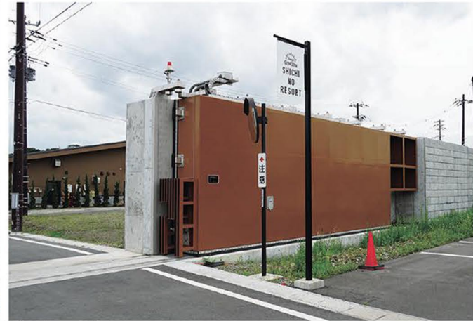
防潮堤のゲート 緊急時にはスライドさせる
