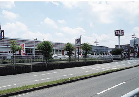
店舗は幹線道路に面している
