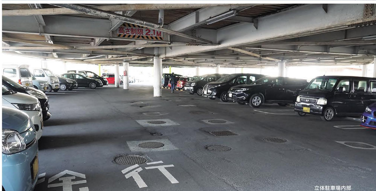
立体駐車場内部
