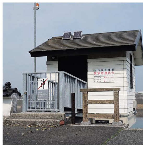
水門管理小屋には緊急連絡先が表示
