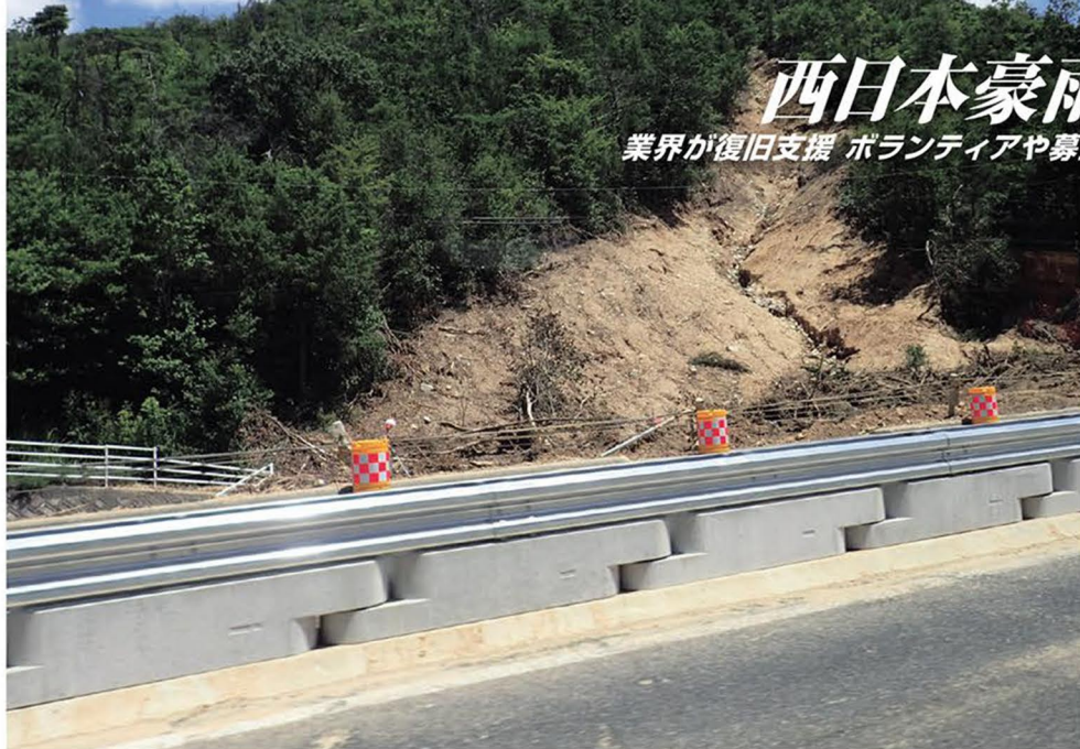
山陽自動車道を走ると土砂崩れの跡が
