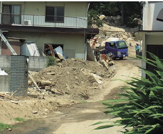
土砂が積み上げられている(広島県海田町)
