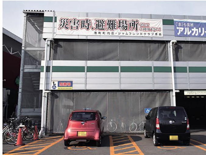
避難場所の横断幕が立体駐車場の壁面に
