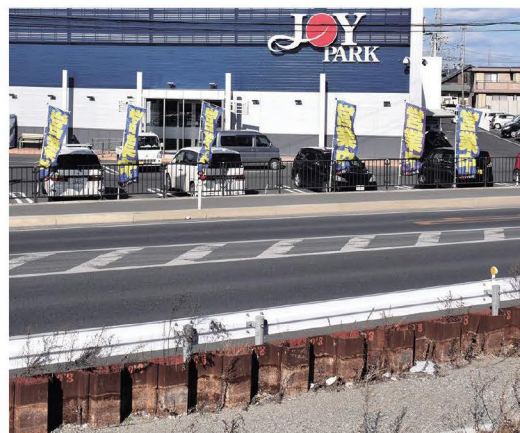
土手沿いに鉄板が打ち込まれている
