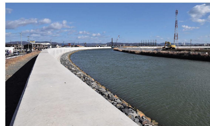
定川の堤防工事が進められていた
