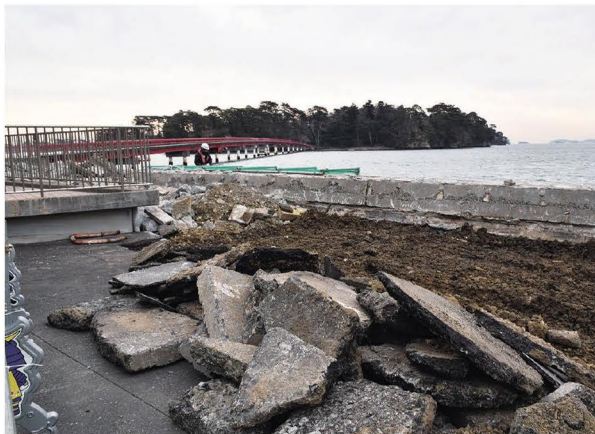
防波堤の工事(松島湾)
