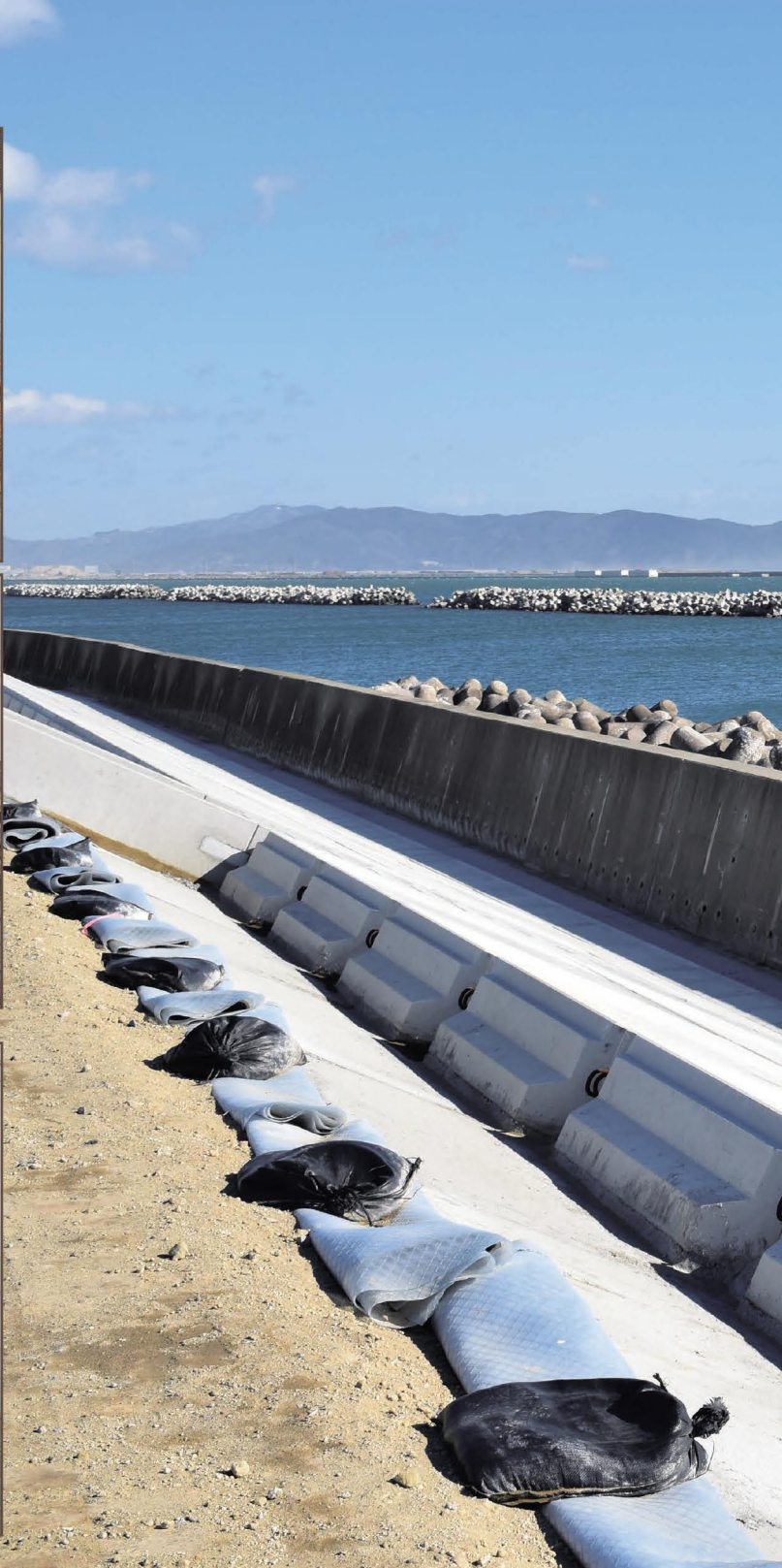
防波堤の工事が進んでいた
