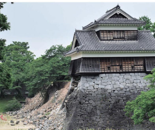
周囲の石垣が大きく崩れている
