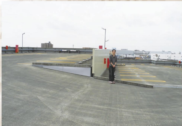
第一駐車場屋上
