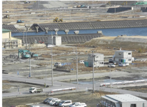
鉄道の橋脚が残っている
