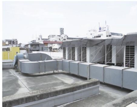
室外機にはネットで日陰をつくっている
