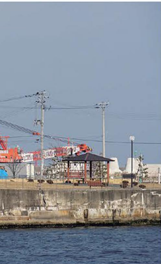
防潮の工事は進行中
