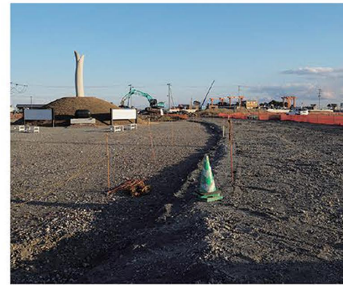
慰霊碑の周辺も工事が進められている
