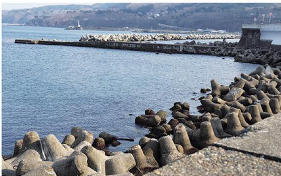
テトラポットが岸壁を守る
