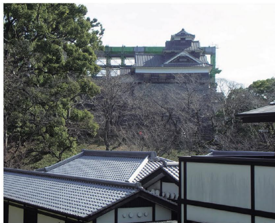
修復へ急ピッチの熊本城
