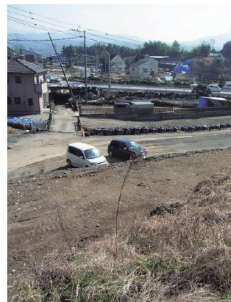
解体工事が進み さら地が目立つ益城町
