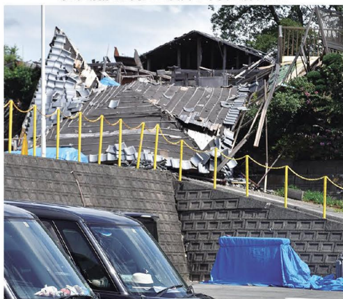
駐車場脇の民家も2度目の本震で崩壊した
