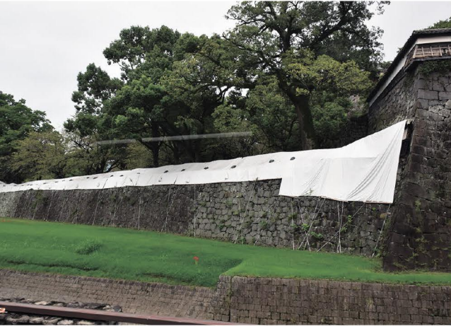
石垣にシートがかぶせられている
