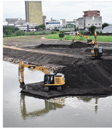
白川では護岸工事が進行していた
