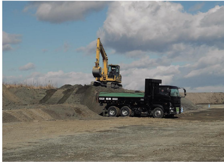
ショベルカーが盛土の作業をしていた
