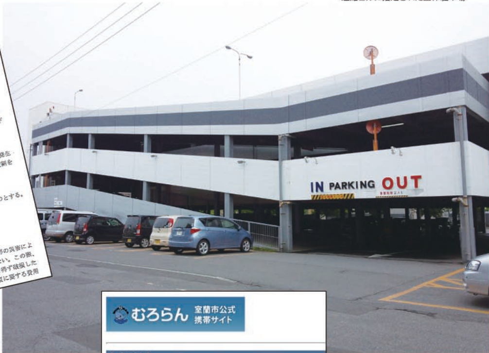
避難ビルに指定された立体駐車場
