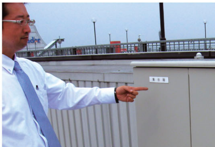
発電した電力を引き込む集合箱
